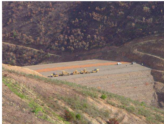
Fotografia 1 - Corpo da ensecadeira em fase de construção. Vista geral do paramento de montante em 27/10/2003 (COBA, 2003a)
